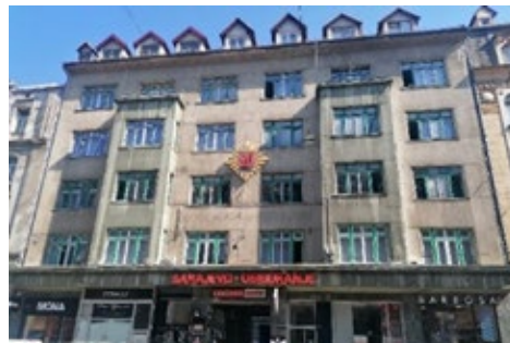
U toku sanacije
